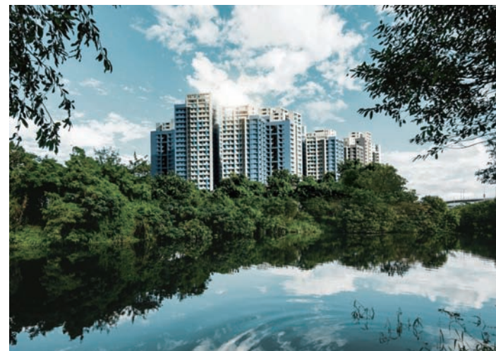
板橋浮洲合宜住宅
