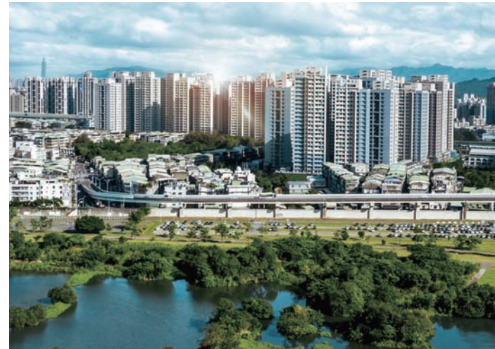
板橋浮洲合宜住宅
