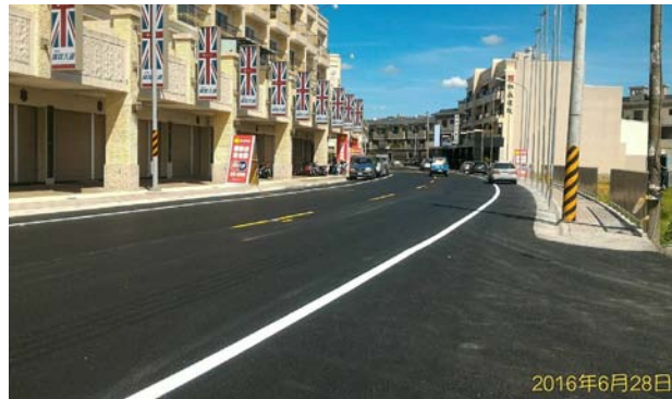
高雄市仁武八德西路拓寬工程
