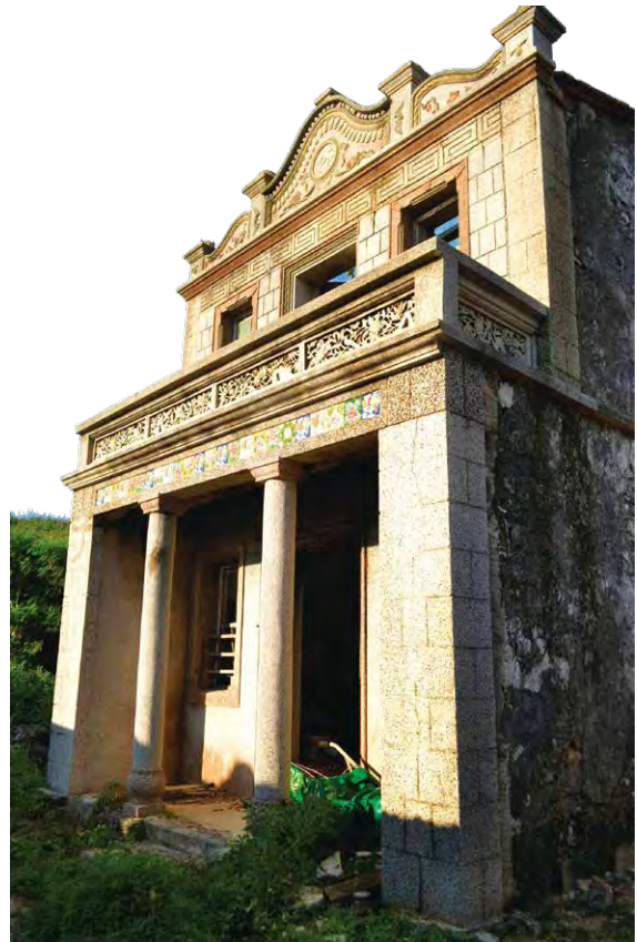
東吉嶼洋樓 林宅
