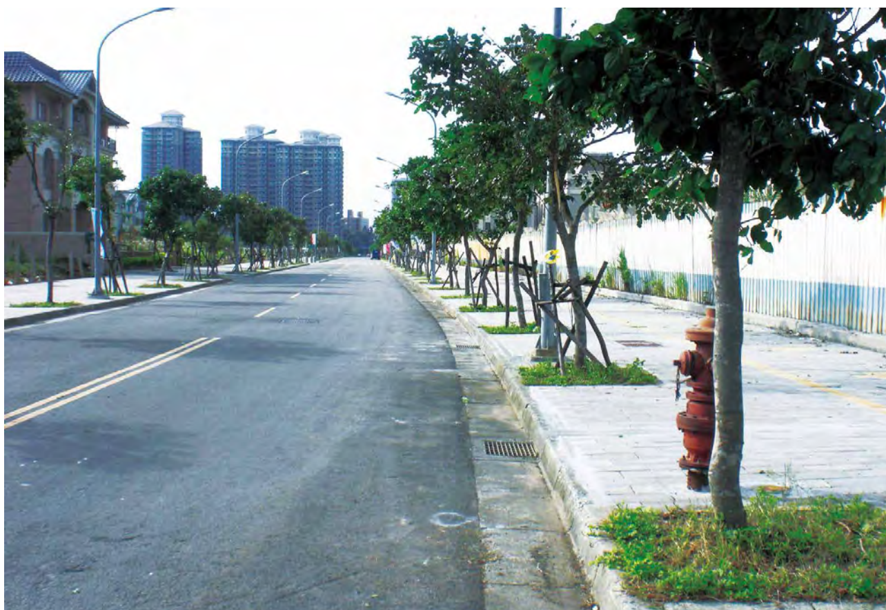
淡海新市鎮第一期發展區第二開發區第二期人行道鋪面及交通工程
