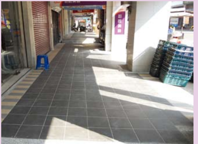
▲ 高雄縣鳳山市騎樓整平施工前、中及完工後成果
