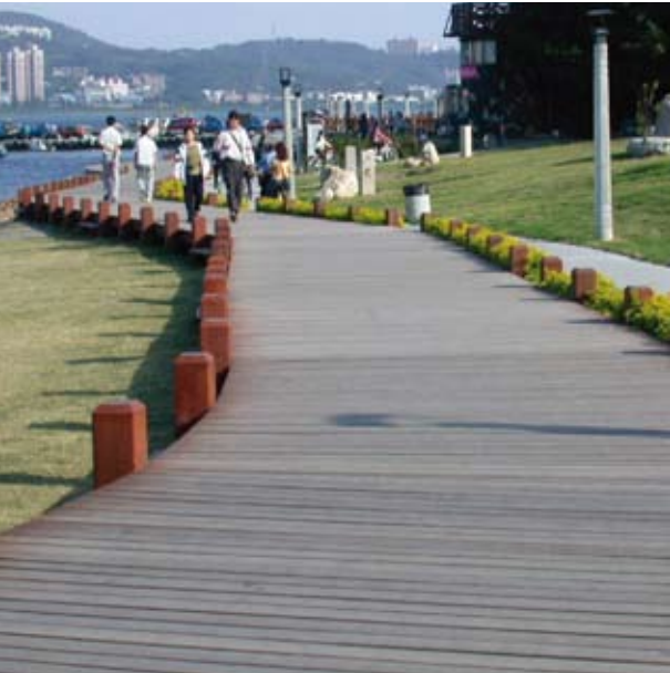
▲ 新北市八里鄉淡水河左岸景觀改善工程
