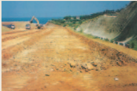
◆ 淡海新市鎮道路工程施工過程
