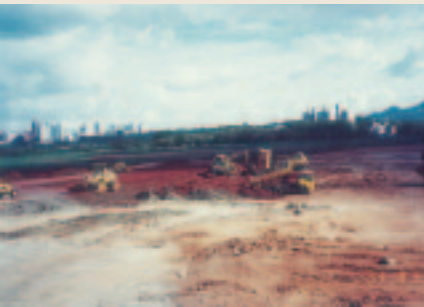
◆ 淡海新市鎮基地整地過程
