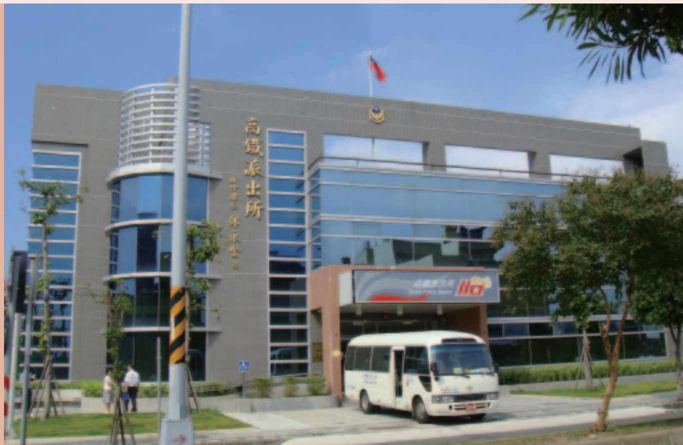
◆ 99 年度公共建築物無障礙生活環境業務督導實地訪視新竹高鐵派出所。
