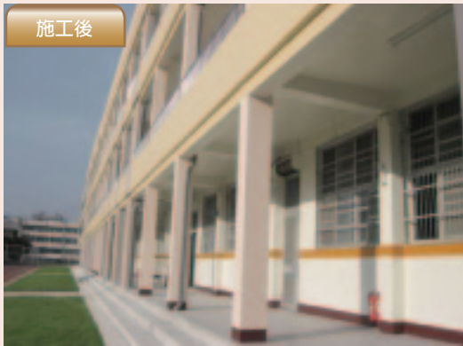
◆臺中市崇倫國中耐震能力評估及補強工程
