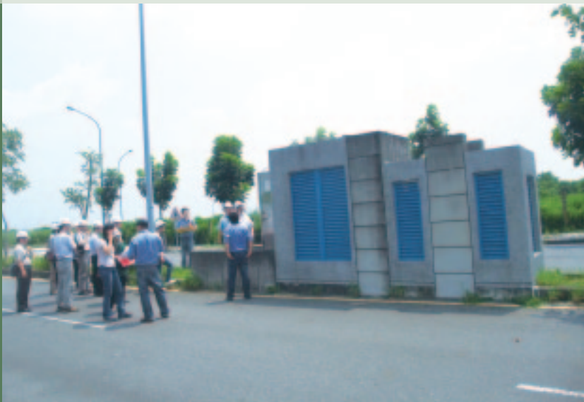
◆ 共同管道人員進出與自然通風口
