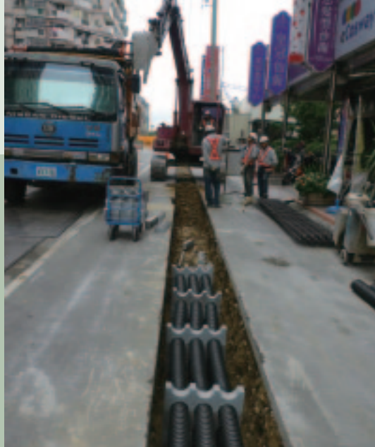
◆ 寬頻管道母管佈放
