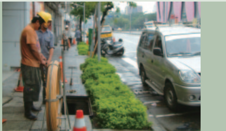
◆ 寬頻管道佈纜作業
