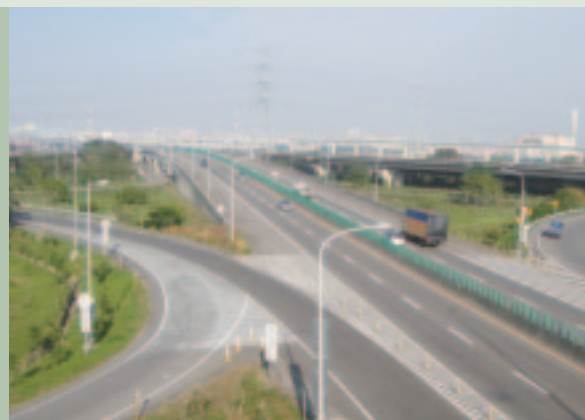
◆ 彰濱臺中線（中彰快速公路）快官系統交流道
