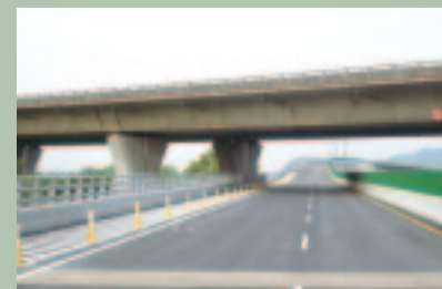
◆ 南投市祖祠橋新建工程
