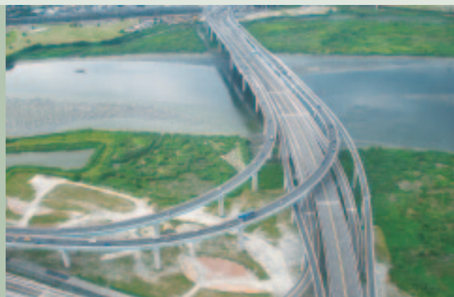
◆ 八里新店線重翠大橋板橋端
