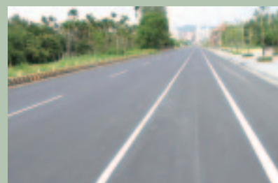
◆ 臺中生活圈二號道路工程（潭子段）
