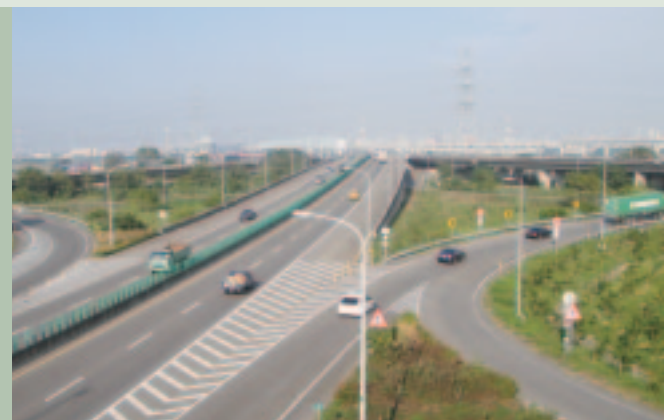
◆ 彰濱臺中線（中彰快速公路）快官系統交流道
