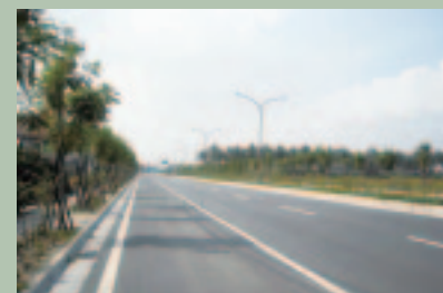
◆ 岡山鎮都市計畫 16 號聯外道路工程
