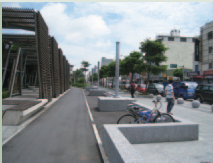
◆ 桃園縣平鎮市延平路人行環境改善工程
