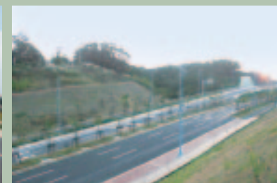
◆ 新竹市客雅溪邊道路工程
