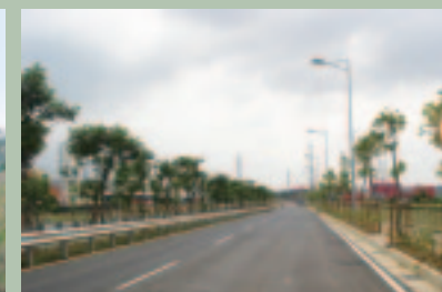
◆ 桃園縣楊梅 1-1 號道路工程
