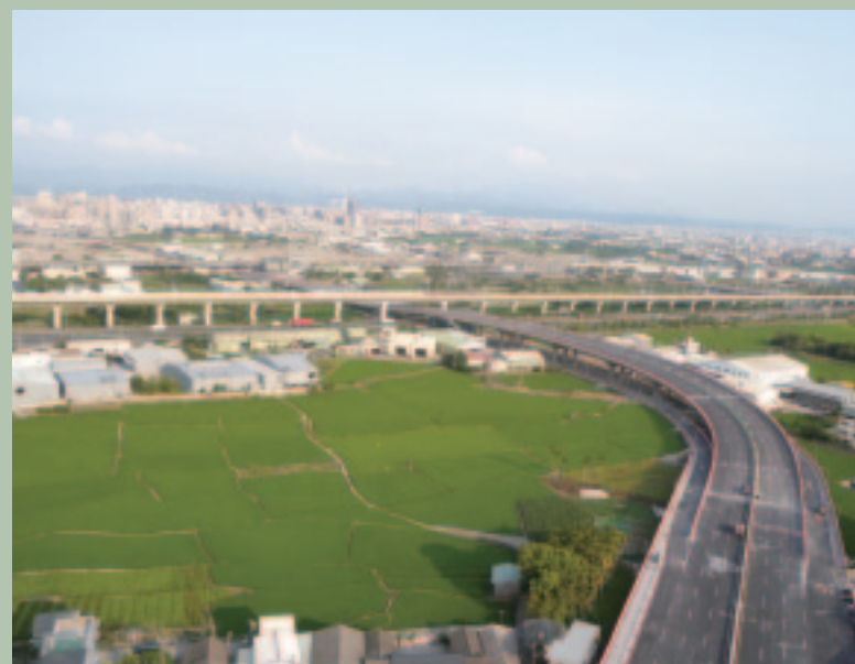
◆ 臺中市特三號道路
