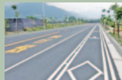
◆ 臺東鐵路新站 4-8 號景觀道路工程
