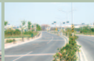
◆ 臺南交流道特定區 28 號及 27 號北段道路工程
