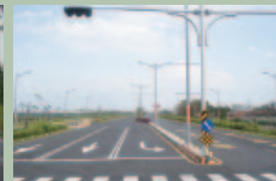
◆ 嘉義縣治 1-4 號道路工程
