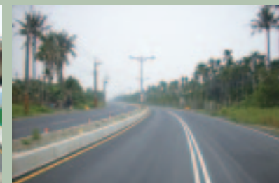
◆ 屏東縣屏東科技大學聯外道新闢工程
