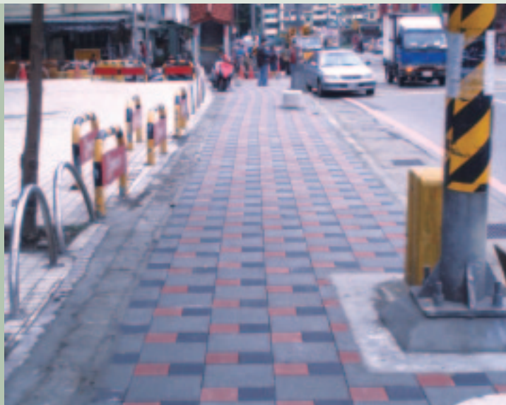
◆ 基隆市麥金路道路景觀與人行環境改善工程
