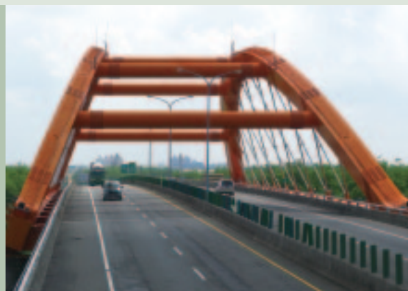
◆ 臺南關廟線跨縱貫鐵路之鋼拱橋
