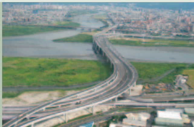
◆ 八里新店線重翠大橋三重端
