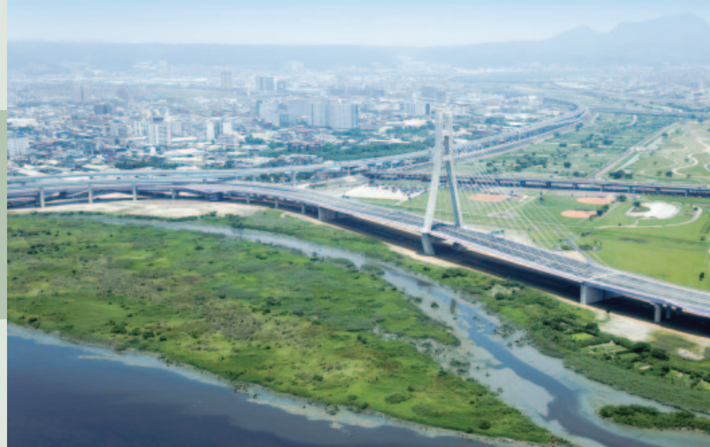
◆ 臺北縣側環快工程第三標斜張橋工程
