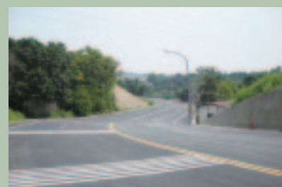
◆ 大寮大坪頂特定區十號道路工程
