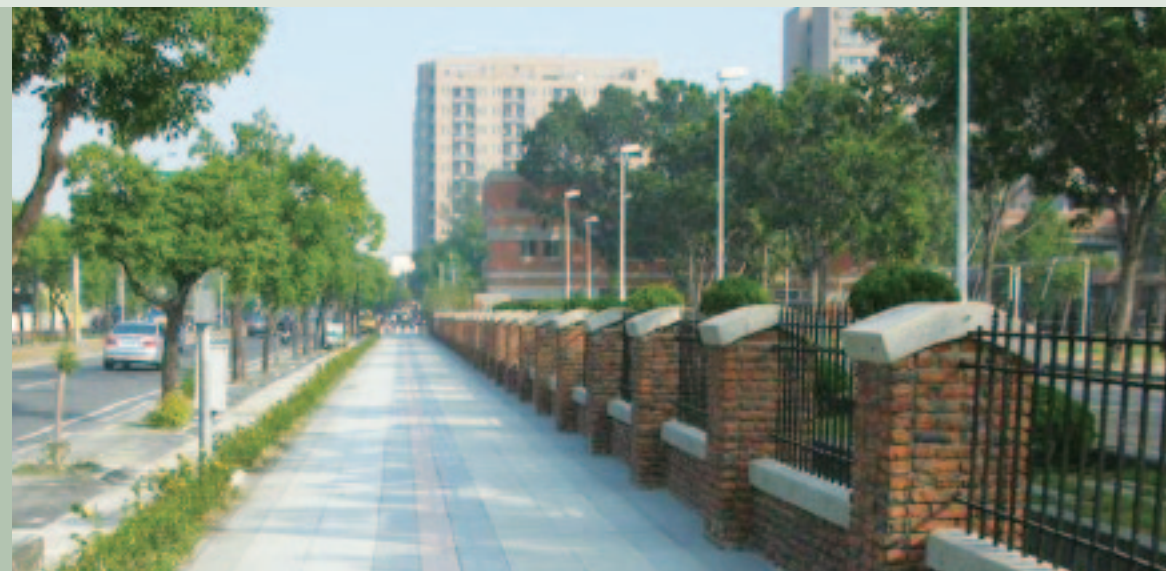
◆ 臺南市長榮路三段大學路至小東路人行道改善工程
