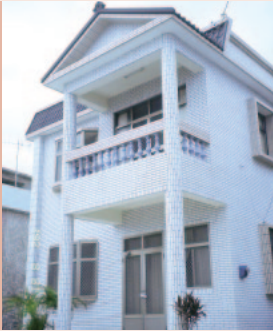
◆ 貸款人民自建住宅（臺東）
