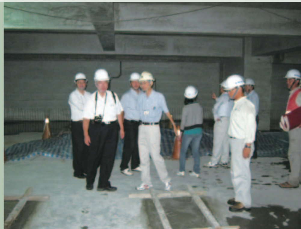
◆ 南工處品質抽查小組抽查鳳山地檢署工程。
