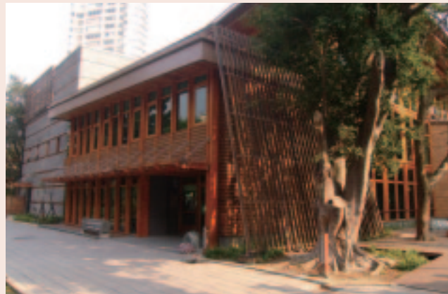
◆ 第十一屆中華民國傑出建築師作品 / 臺北市立圖書館北投分館實景 (張清華建築師事務所)
